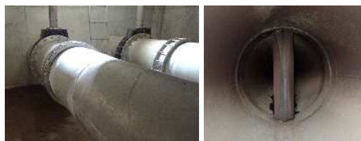
図 3. 既設制水弁 1 の状況
